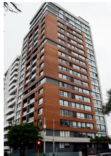
Edificio Sinchi Roca 2504
