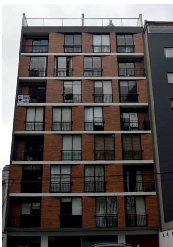
Edificio San Borja Norte 685
