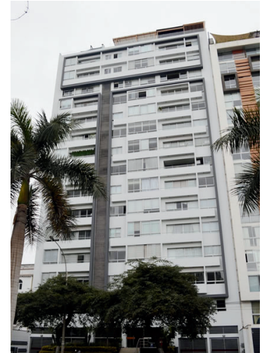
Edificio Javier Prado 2035 Torre Palatino
