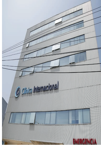
Clínica Internacional Ampliación y Remodelación
